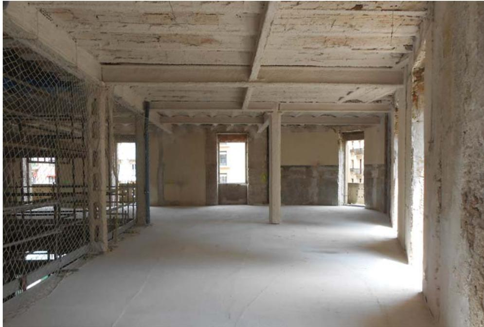
Estructura metálica correspondiente al forjado superior de la planta 2.
