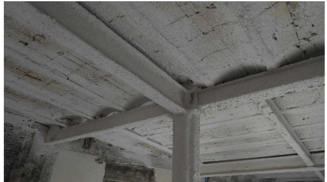
Protección ignífuga de la estructura metálica.
